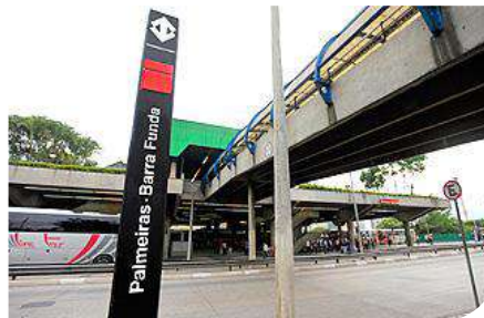
Estação Palmeiras – Barra Funda
